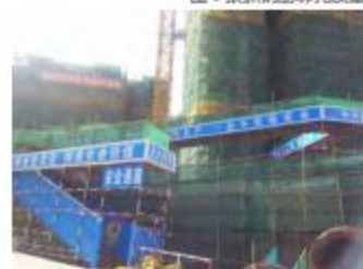
图：现场安全通道
