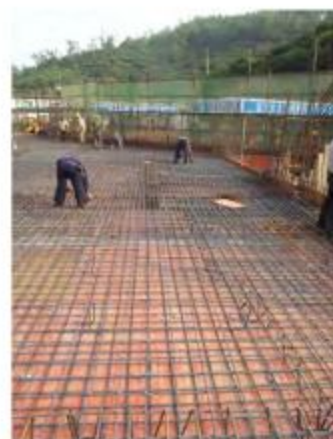
图：振振钢筋绑扎质量
